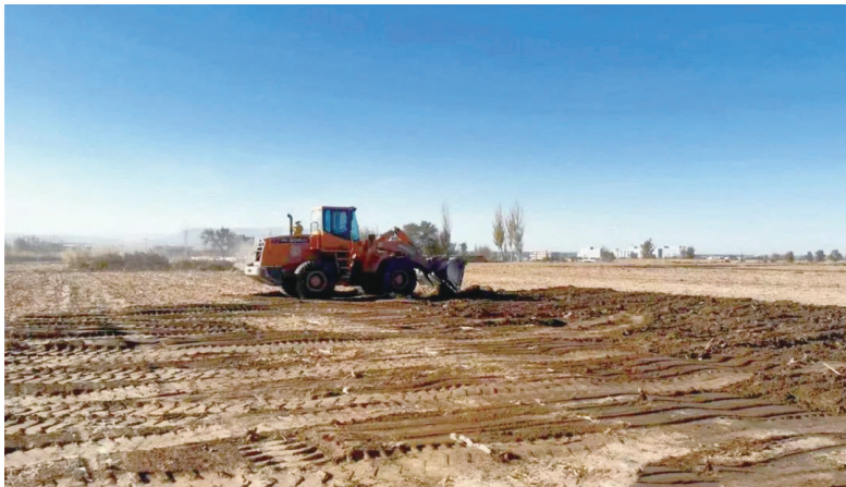
近日,在甘肃省武威市凉州区韩佐镇头哇村高标准农田建设现场,大型机械来回穿梭,平整地垄、开挖渠沟、清运土方等作业快速进行,现场一派热火朝天的忙碌景象。 金奉乾 摄
