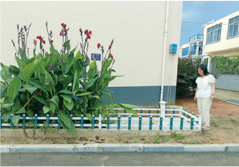
瑞昌市范镇红岗村一户村民家的“小型湿地”式化粪池。
