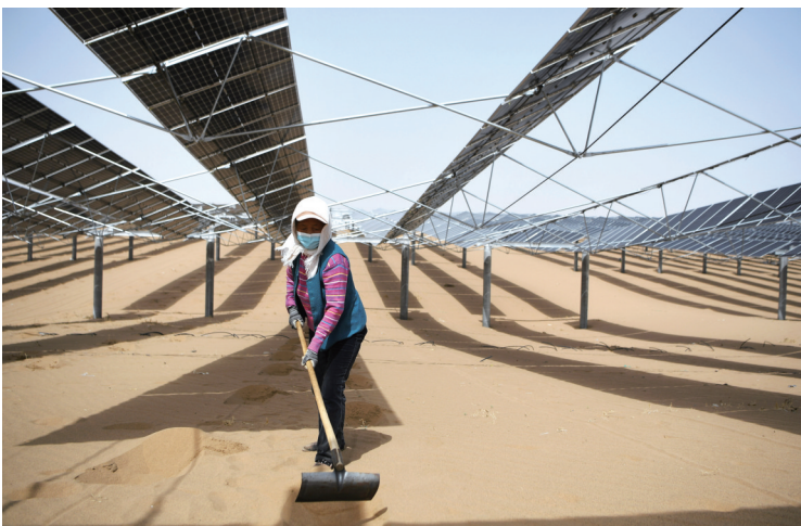
5月19日,在甘肃省武威市凉州区九墩滩光伏治沙示范区,工人在光伏板下挖沙坑准备栽植耐旱沙生植物。
