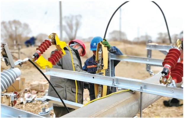
近日，内蒙古鄂尔多斯供电公司赶在春耕用电高峰前，对城川镇糜地梁嘎查及周边边区6条主干线电力设施全面升级改造。据了解，此次升级工程共计新建及改造10千伏架空线路42.98公里、电缆线路3.79公里，惠及1000多名农牧民。图为工作人员在鄂尔多斯市鄂托克前旗城川镇糜地梁嘎查进行电网升级作业。张悦 摄
