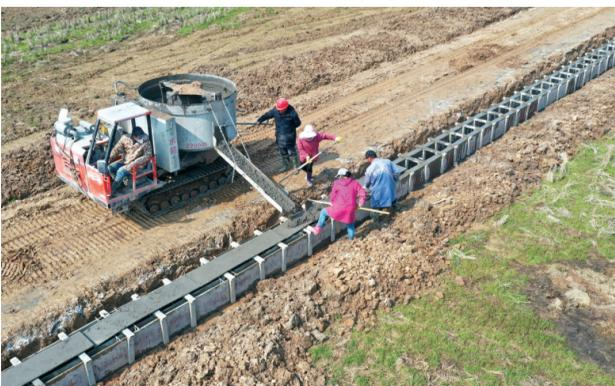
连日来,江西省吉安市永丰县水利施工队伍加班加点建设灌溉排涝工程,利用晴好天气把前期因持续降雨耽误的工期抢回来,保障水库灌区春耕生产灌溉用水。图为2月16日永丰县七都乡车头村水利工地上,施工人员正在修建节水灌溉渠道。刘浩军 摄
