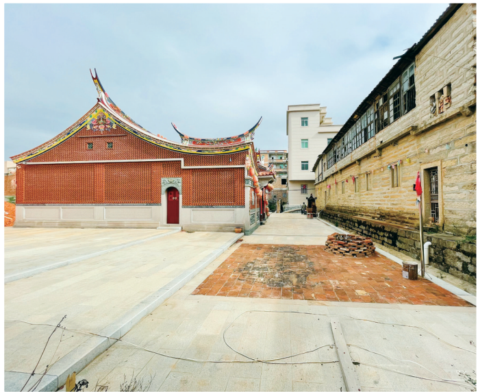
东石镇潘山村东隘门路改造前。
