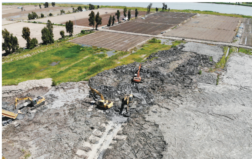
今年以来，浙江省台州市路桥区在党建引领下开展抛荒耕地专项整治，防止耕地“非粮化”“非粮化”。图为在路桥区金清镇，挖土机正在对抛荒的耕地开展复耕平整。 蒋友青 摄
