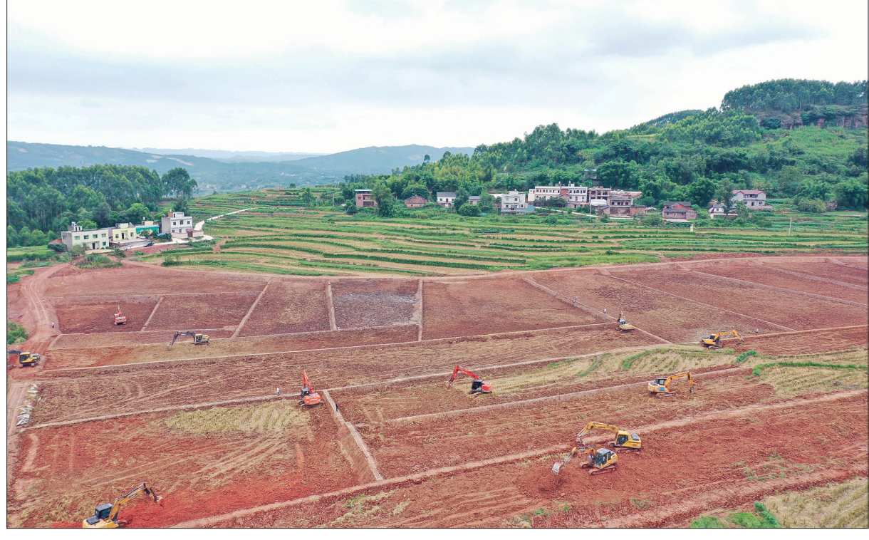
重庆市永川区金龙镇金鼎村高标准农田建设现场。
