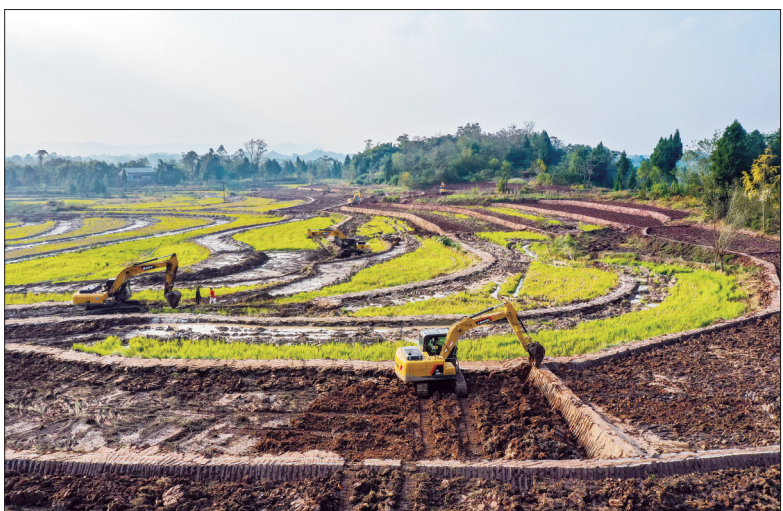
近日,在四川省广安市广安区花桥镇现代农业园区内几台挖掘机正在平整土地。该镇抢抓冬季农田水利建设的有利时机,组织足够机械和人员推进高标准农田建设,目前已建成高标准农田0.96万亩,到2023年园区内将实现高标准农田全覆盖。 张国强 罗青山 摄
