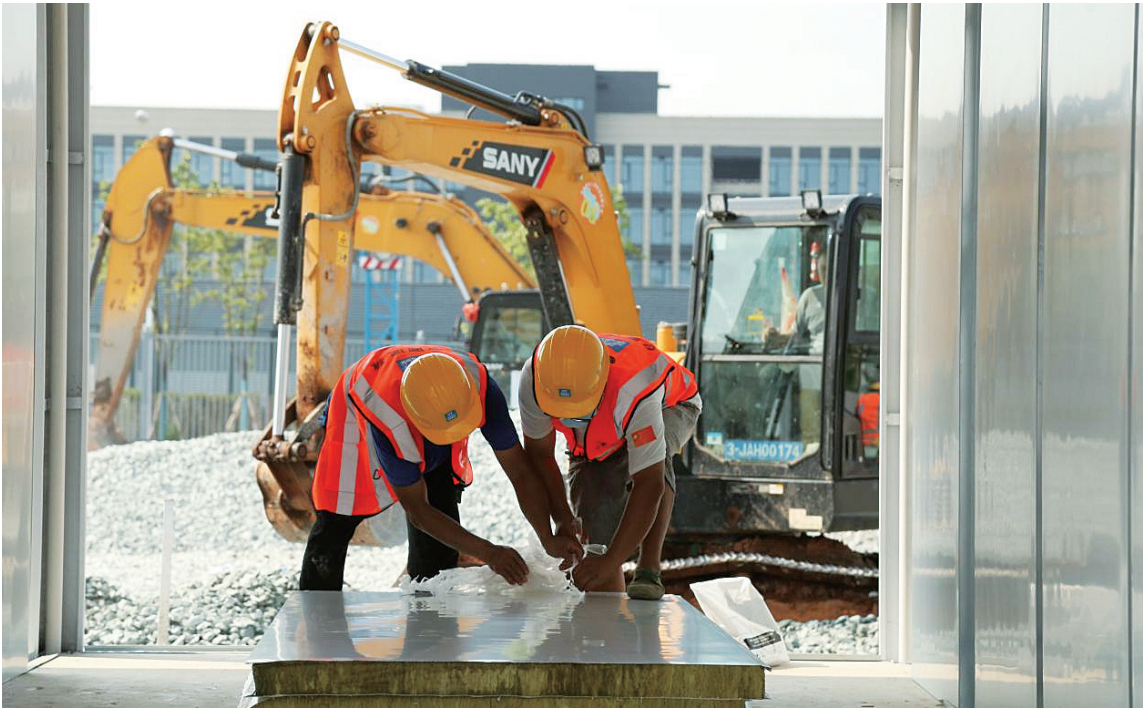
9月1日，由中建五局三公司承建的“涉及高风险工作人员保障集中居住区”项目在湖南省长沙黄花机场顺利交付。项目历时20天，500名农民工克服高温多雨天气，采用“多班倒”作业方式，保持机械设备不停歇作业，最终提前完工。
