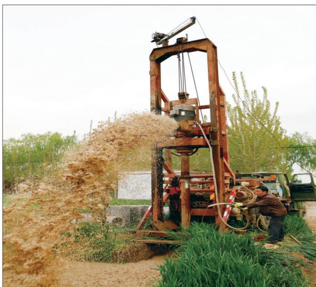
近日,在山东省济宁市微山县昭阳街道高标准农田建设项目区,施工工人正在操作机器打机井。该项目区规划面积1.15万亩,包括新打机井136眼、硬化田间道路14275米、新建涵洞12个、新建排灌站1处等田间基础设施工程,为加快转变农业发展方式、调整农业经济结构起到基础性作用,为农业增产、农民增收奠定坚实基础。
