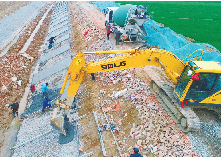
春季以来,山东省阳谷县针对部分农田水利设施超负荷、压力大、相继损坏的实际,结合春灌和防汛,组织人力物力财力统一对全县农田水利基础设施进行升级改造。目前,全县已升级改造桥、涵、闸90余座,加固河坡、河堤120余公里,有效提升了春灌和防汛排涝能力,为今年农业丰产丰收打下坚实基础。图为阳谷县石佛镇柳阳沟渠,工程施工人员在用水泥对两边河坡进行加固升级改造。
