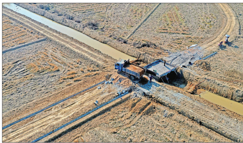
近日，江西省吉安市永丰县七都乡鹤颈水库灌区，施工人员在修建农田灌溉渠道。入春以来，永丰具备耕先备水，充分利用晴好天气，争分夺秒打好冬春水利建设扫尾攻坚战，保障春耕生产灌溉用水。图为修建农田灌溉渠道现场。 刘浩军 摄
