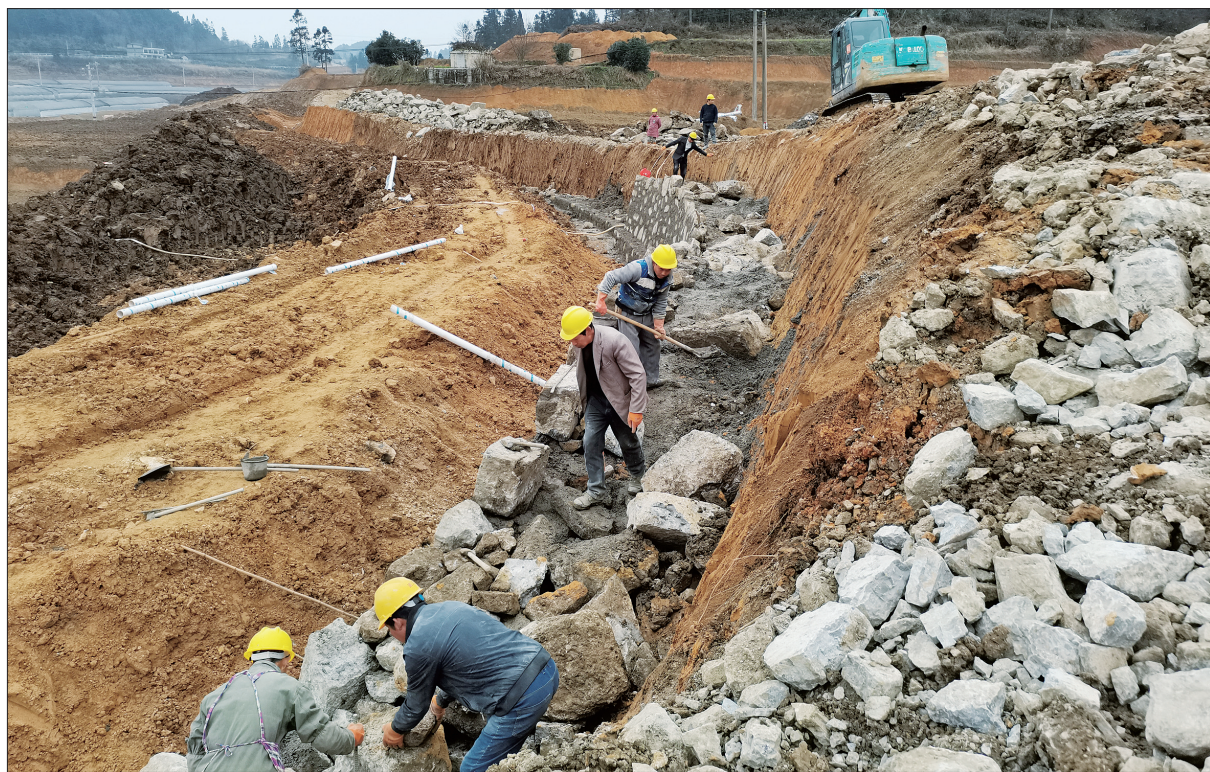
贵阳市乌当区高标准农田建设施工现场。
