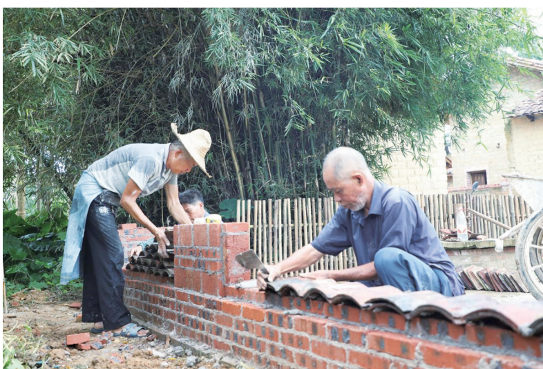
玉林市福绵区福绵镇十丈村村民正在修建粪污集中处理池。
