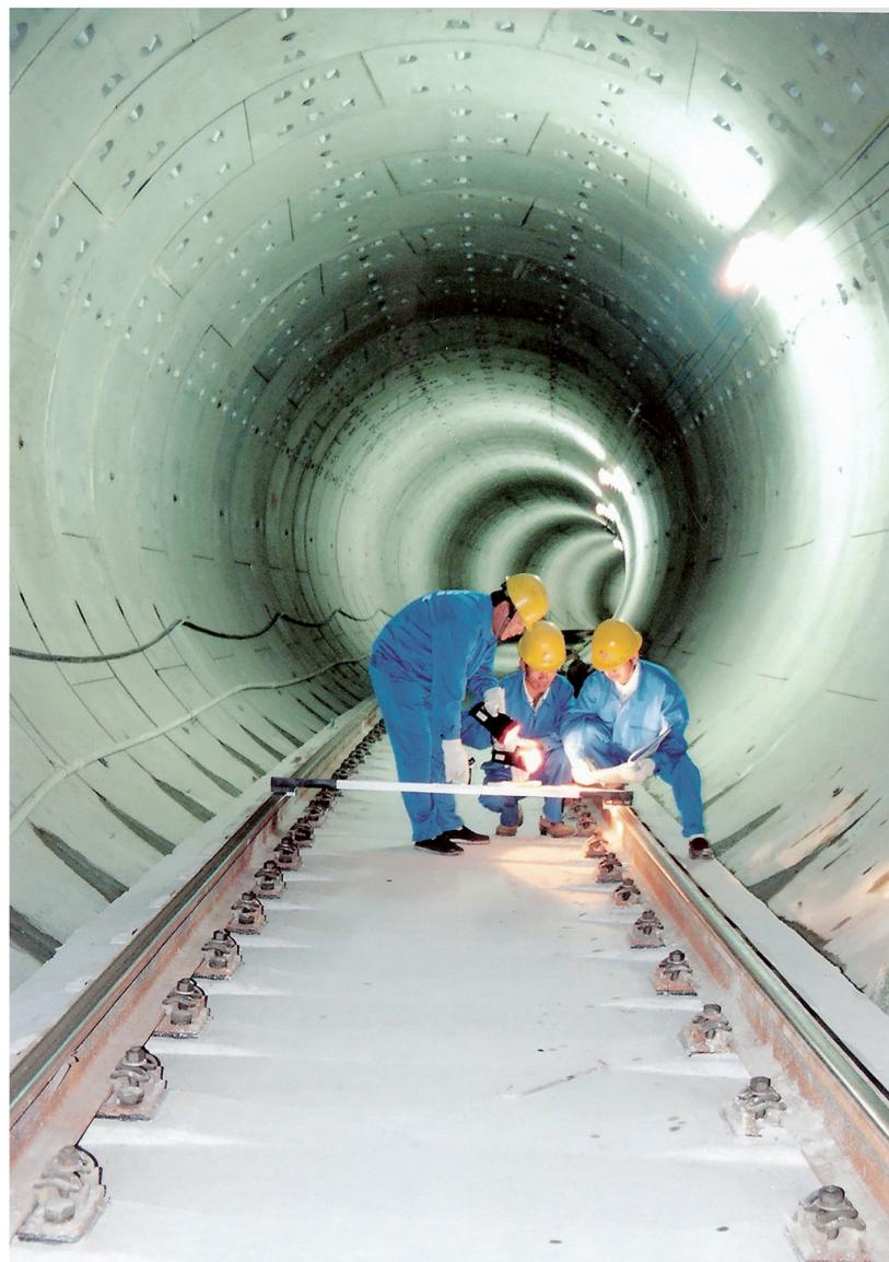
在浙江杭州地铁10号线全线通车前,工人进行轨底坡测量。付海 摄
