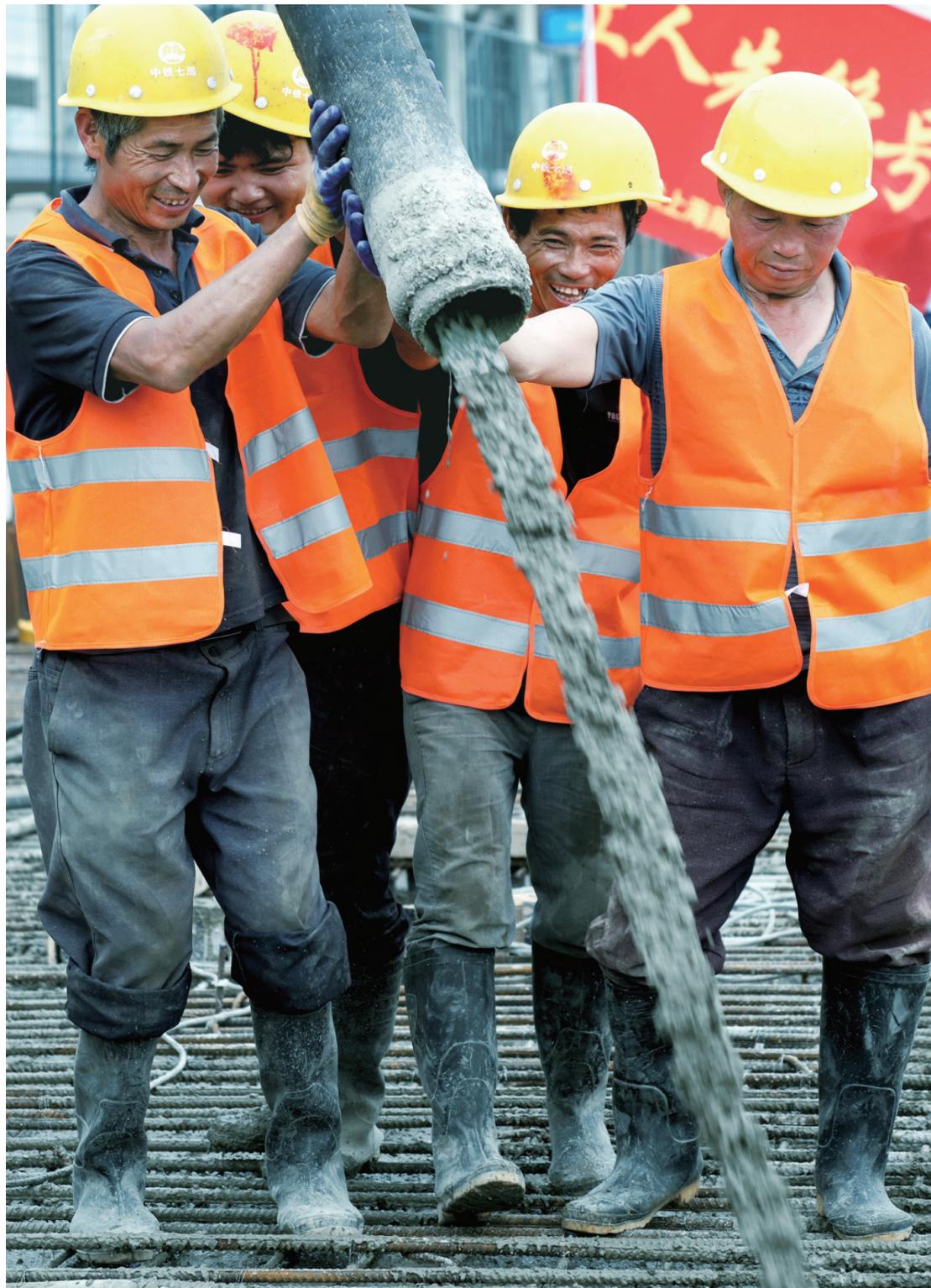
6月12日,建设南沿江城际铁路的工人在太仓高架站浇筑箱梁混凝土。叶晓宁 摄
