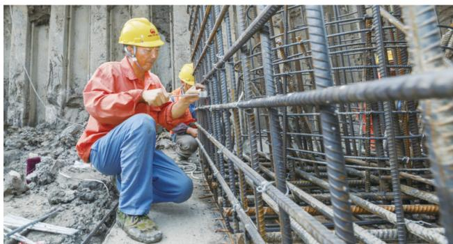
6月22日,上海S7-3标项目的钢筋工在绑扎承台钢筋。张钰 摄
