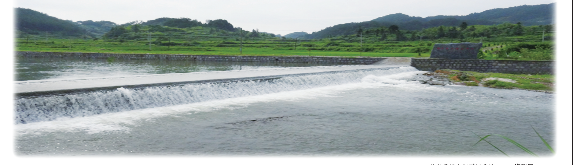
旌德县徽水河灌溉系统。
