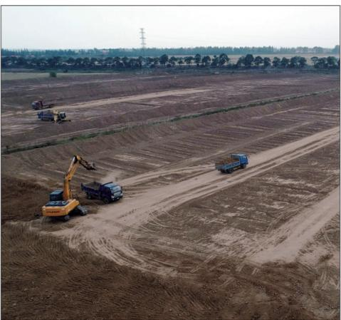
在安徽省安庆市,华阳河农场把种植结构调整与高标准农田建设相结合,通过土地平整、开沟建渠、田间道路及绿化带建设,推动生态绿色农业稻渔综合种养发展。工程完成后,每年可新增粮食7000吨,种养产值增加2000万元以上。图为农场采用大型推土机和运输车辆对土地耕作层进行剥离,实施土地平整,以建设2万亩集中连片的高标准农田。
