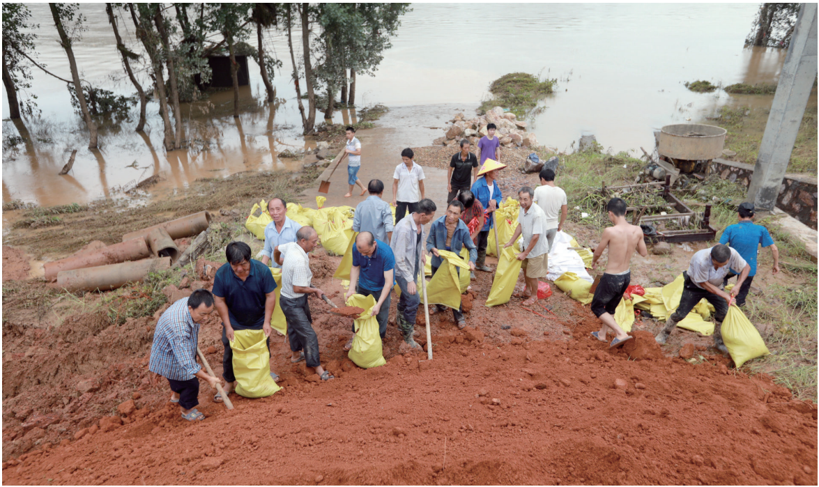
7月12日,在湖南省衡阳市衡东县吴集镇杨梓坪村,村民和衡东县干部一起冒雨连夜修复加固河堤,准备迎战新一轮洪峰。周健 本报记者 张振中 摄
