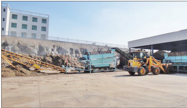
位于山东青州市的尾菜堆肥工程正在进料。
