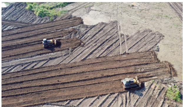
9月20日，安徽省宿松县属农垦华阳农场，农机手驾驶大型推土机进行土地平整作业。今年，该农场依托项目工程，计划投资6000万元，对4039亩工程取土区进行复垦。通过土地平整、田间道路、灌溉与排水系统等建设，打造高标准农田，助力粮食增产增收。
