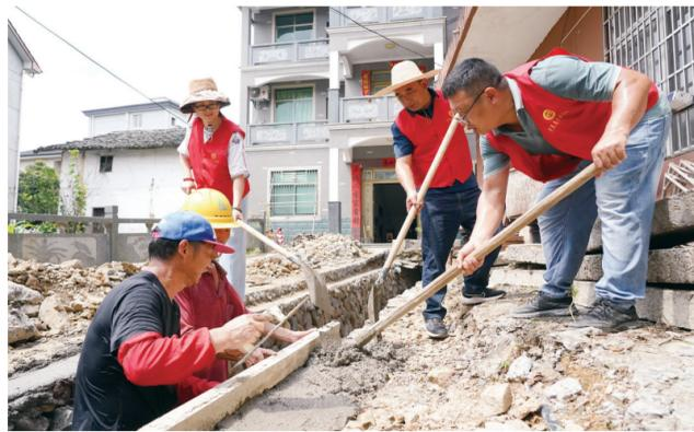
面对汛后的高温酷暑天气，浙江省桐庐县百江镇组织各村党员干部带头顶烈日抢修水毁工程，尽早恢复村民正常的生产生活。图为近日百江镇东辉村的党员干部在抹水泥、砌砖石修复被洪水冲毁的沟渠。徐军勇 江凌浩 摄
