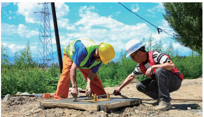
近日,新疆博尔塔拉蒙古自治州精河县实施了5G智慧路灯建设安装项目。据了解,该项目通过远程集中控制的方式对路灯进行管理,通过风能和光能互补的形式,实现碳排放“零污染”。因为在托里镇大庄子村路口,工人对路灯底座浇筑的混凝土进行抹匀、找平。
