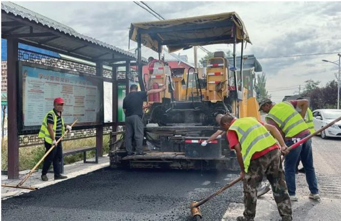
近日，位于新疆伊宁市克伯克于孜乡主路段的农村公路养护及安防工程正在进行道路路面工作。长达2.045公里的路段呈现一派繁忙景象，大型摊铺机、压路机等机械轰鸣作响，沥青混凝土被均匀铺设。在完成提升改造后，将为村民出行带来极大便利。图为工人们正在铺设沥青。
