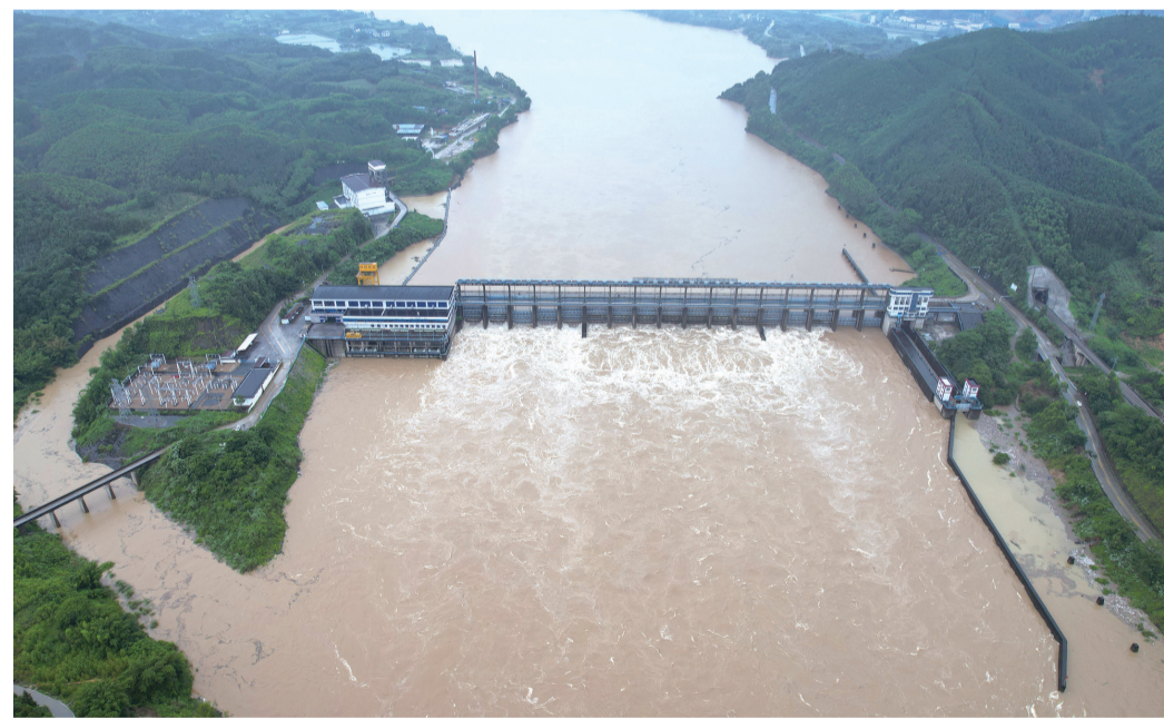
六月十七日,融江广西柳州市融安县浮石水电站开闸泄洪。连日来,针对持续降雨和汛情,我国南方各地积极做好预报预警、防灾减灾、救灾救助等工作,力求最大程度减少损失。谭克兴摄 新华社发
