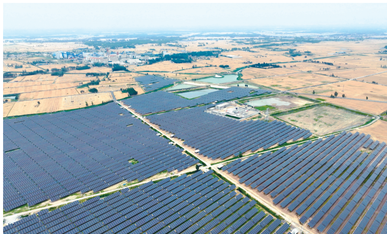
近年来,山东省济宁市嘉祥县统筹推进采煤塌陷区综合治理与清洁能源开发,2023年引入中国华能集团在嘉祥县梁宝寺镇采煤塌陷区建设集光伏发电、农业种植于一体的“农光互补”光伏电站项目,提升采煤塌陷区综合利用效能,助力乡村振兴。图为梁宝寺镇利用采煤塌陷区建设的华能嘉祥梁宝寺光伏项目。
