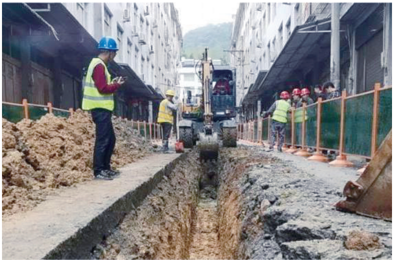
自2022年福建省福鼎市入选福建省第一批农村污水治理试点县以来,全县积极推进农村生活污水治理。截至目前,福鼎市污水治理项目范围涵盖全市13个乡镇,新建污水处理厂54座,污水提升泵站29座,污水管道近1500公里,搭建污水智能化监管平台,加快补齐福鼎市农村生活污水治理短板,进一步提升农村生活污水治理率。图为福鼎市龙安开发区的污水管网建设现场工作人员正在施工。王阿宁 摄
