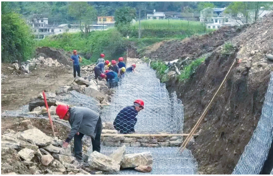
近年来,贵州省思南县以水系、村庄和城镇周边为重点,统筹推进人居环境提升,全面开展小流域水土流失综合治理工程,有力促进了乡村振兴发展。目前项目新建人居环境整治新建污水收集管道800米,新建防护堤1条全长1560米,岸坡绿化1760米,治理小流域8条,惠及5个乡镇、43个村、47433人。图为张家寨镇生态清洁小流域施工现场。刘婷 摄
