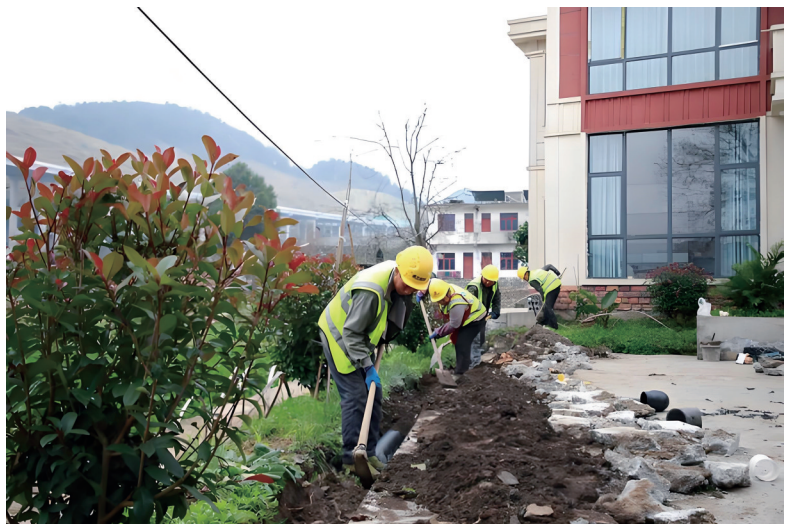
近年来，贵州省绥阳县分类施策，扎实推进污水治理工程。绥阳县根据不同的现场条件，分别采用无人机、全站仪、潜望镜等设备，完成了县城区9个社区和14个乡镇的管网排查工作。累计排查管线长度321千米，检查井等各类节点9099座。目前，已完成全县11个乡镇的改造工作，完成总工程量的80%。图为施工人员从郑场镇卧龙社区村民家连接污水管道。
