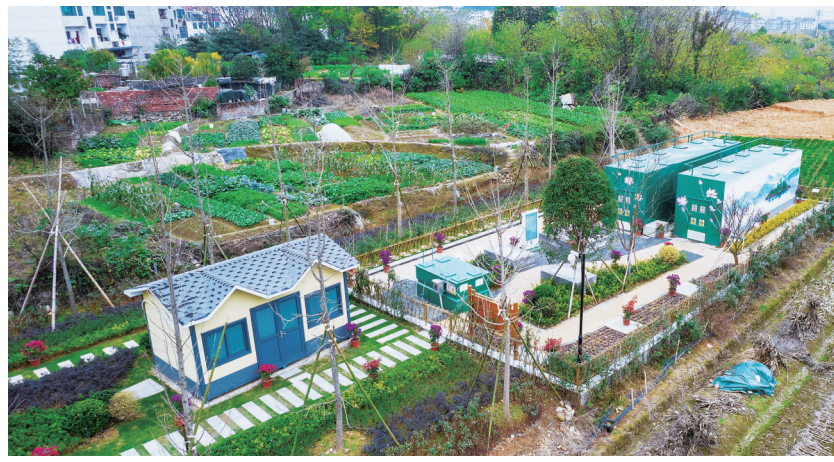
图为“问源环保”在浙江省浦江县仙华街道十里头村的农村生活污水治理项目。
