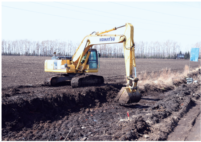
连日来，在北大荒集团建设农场有限公司高标准农田的侵蚀沟治理施工现场，施工人员驾驶专业机械正进行高标准农田侵蚀沟治理工作。据悉，通过柳编护沟、秸秆填沟、柳跌水、石谷坊、格宾石笼护砌、沟道削坡、沟坡防护林等措施进行侵蚀沟治理，能够防止水土流失，保护黑土地，提高粮食产能。 许颖斌 摄
