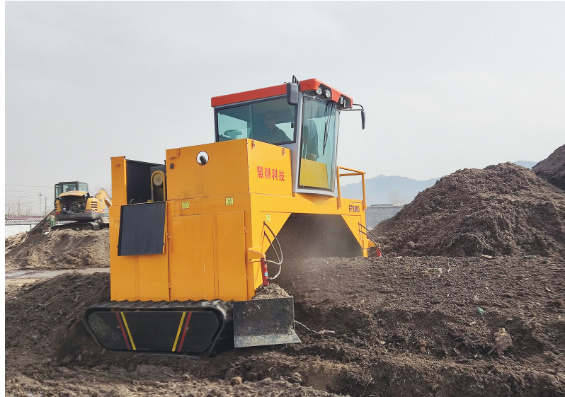
在北京市昌平区流村镇农业废弃物综合处理站，一辆翻抛机正在作业，帮助废弃物发酵成肥。
