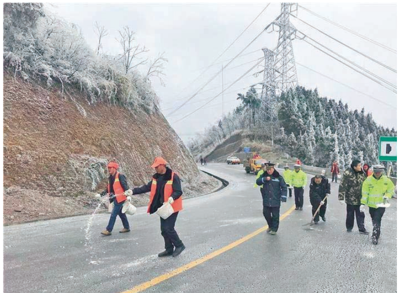
为解决乡村公路人工监测难、预警不及时等问题,贵州省普安县在易发多发事故路段试点建设路而凝冻防控综合数字化管理系统,减少了乡村公路安全事故的发生。图为管护队接到凝冻预警后,对青山镇煤炭坡路段进行人工撒盐除冰作业。 周树颜 摄
