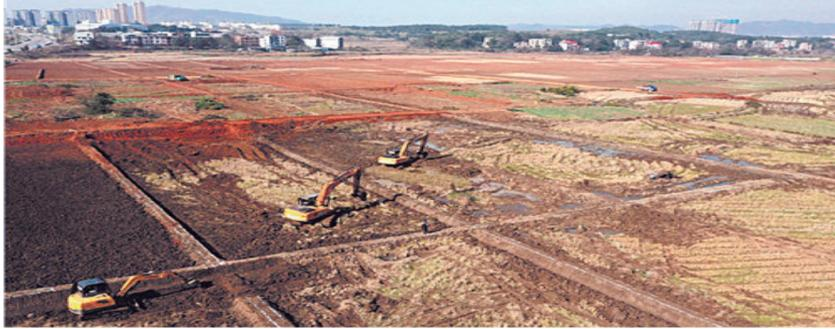
日前,在湖南省宁远县桐山街道高福村,挖掘机正在平整土地、修筑田埂。近年来,宁远县充分利用农闲时节加紧推进高标准农田建设,提升配套设施水平,改善农田灌溉及耕作条件,并将农田建设与区域生态治理、农旅融合、产业规模化发展相结合。骆力军 乐水旺 摄
