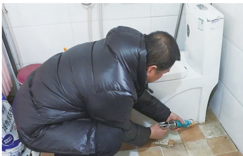
近年来，内蒙古突泉县永安镇组建“泥抹抹”志愿服务队，常态化开展户厕维修服务。图为永安镇“泥抹抹”志愿服务队队员到四家子村村民村补余余开展维修服务。 程阳 摄
