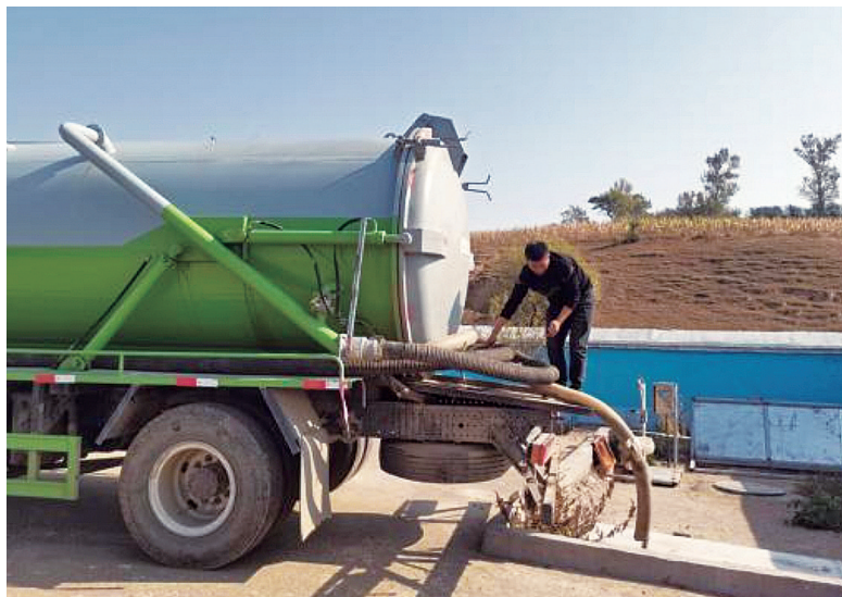
近年来，为扎实推进农村生活污水治理工作，内蒙古通辽市库伦旗制定了农村生活污水治理设施运行维护管理机制，结合农村改厕，采用污染治理与资源利用相结合的方式，统筹开展各嘎查村污水治理项目。图为白音花镇海力斯嘎查污水处理厂正在处理污水。 美娜 摄
