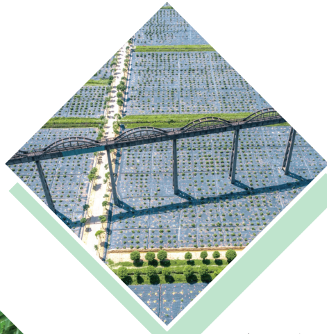
春华渡槽是湖南省跨度最长的大型农业水利设施，全长2100米，高25米。半个世纪过去了，春华渡槽仍可以开槽渡水。 涂向东 摄
