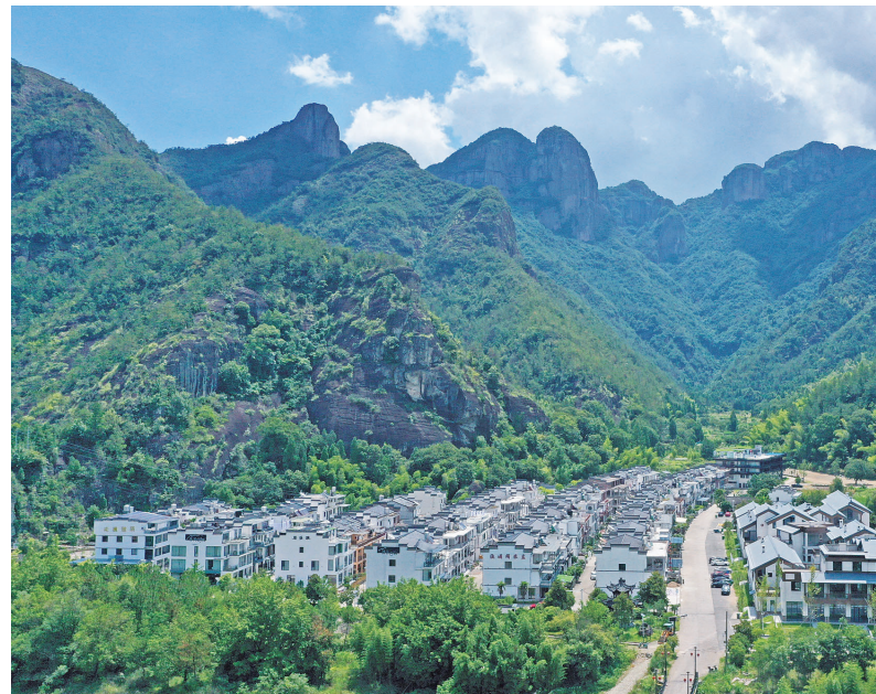
浙江省仙居县淡竹乡下叶村石盟洋民宿村全景。 王华斌 摄
