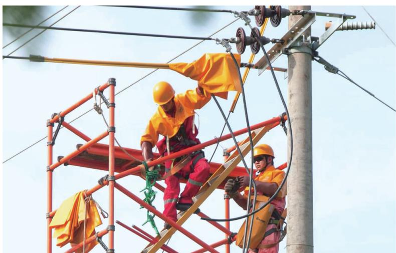
近日,在浙江省衢州市风林镇,国网浙江电力工作人员正在采用绝缘脚手架地形作业操作,对位于农田中的10千伏线路进行带电断接引作业。据了解,绝缘脚手架最大的特点就是不受地形限制,可以在绝缘斗臂车无法到达的农田、山林中开展带电作业,不仅安全系数更高,而且能有效减少作业人员的体力消耗。
