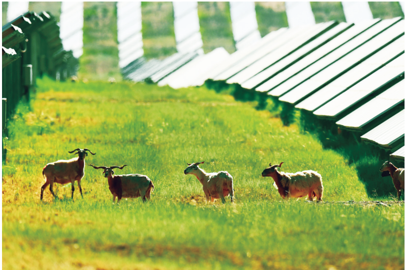
青海省海南州借助光伏发电产业，大力发展“板”下经济，在光伏电站种植牧草，养殖“光伏羊”。
