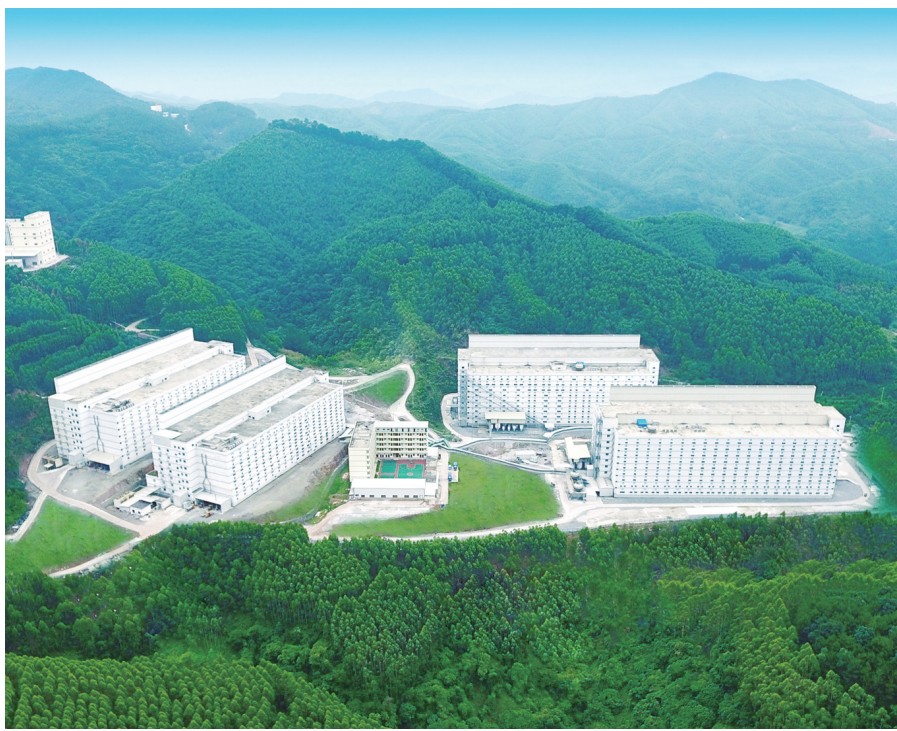
扬翔公司“铁桶”楼房智能化猪场。
